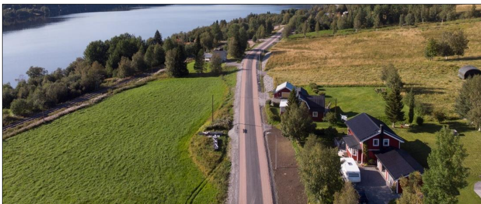
Figur 4.1.3 Järnvägen Mittbanan och väg 659 väster om E14 i utredningsområdets södra del. De rosa ytorna utgör generösa vägrenar på båda sidor om körbanan. Foto mot nordväst med Åresjön i bakgrunden. Till höger, ej synlig i bild ligger E14.
