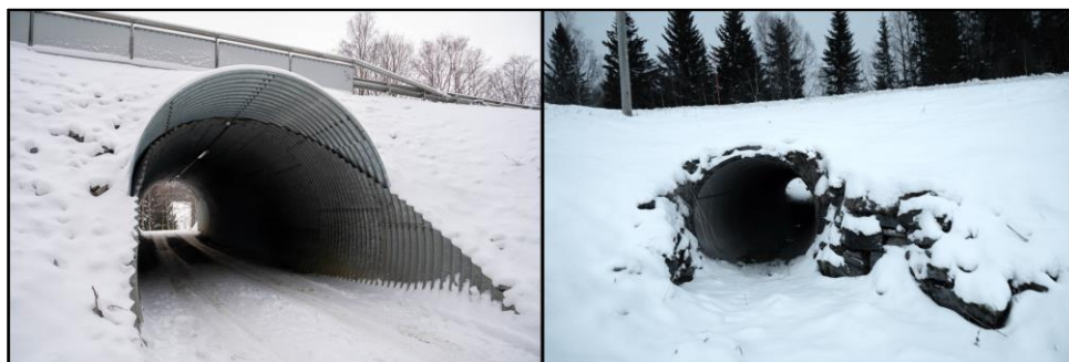
Figur 4.6.5.3 Bild till vänster visar bro 868 från norr mot söder. Till höger är bro 1095 som är en så kallad "koport". Bild tagen mot norr.
