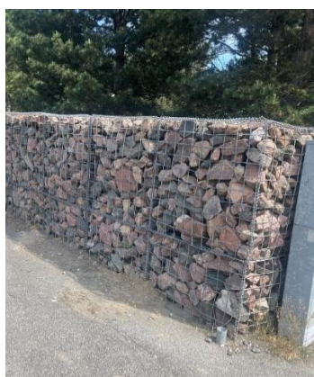
Figur 15. Gabionmurar fyllda med sten, upplevs inte lika monotona som L-stöd av betong.
