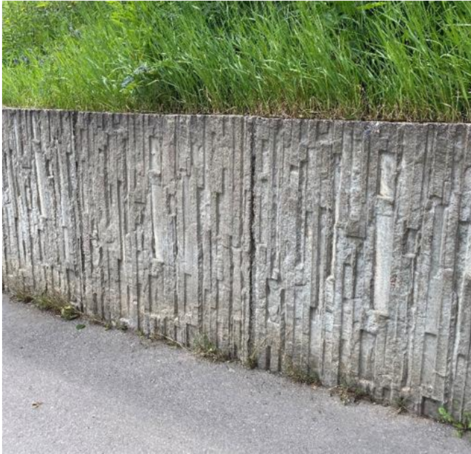
Figur 32. Bergväggsliknande reliefmönster på L-stöd.
