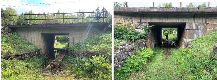
Figur 30. Till vänster norra bron byggd 1951 och till höger södra bron byggd 1857, med ny överbyggnad 1951.
