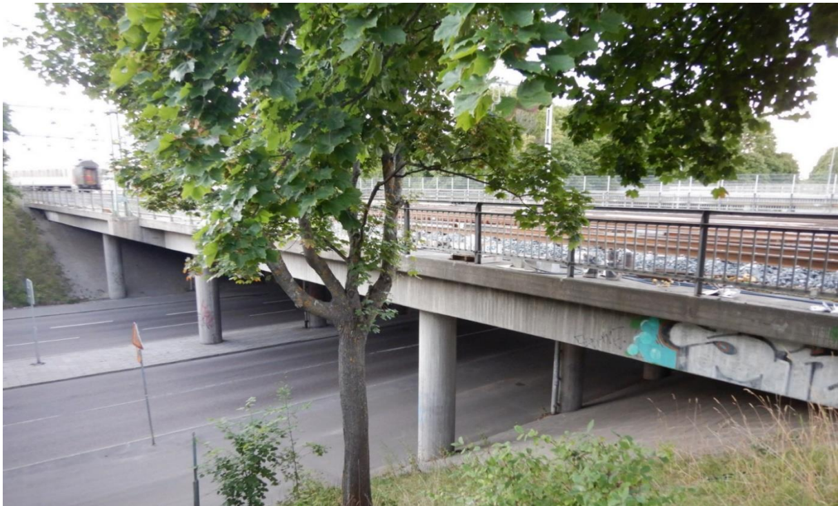
Figur 8. Broar över Staketgatan. Källa: BaTMan 2022-08-29.
