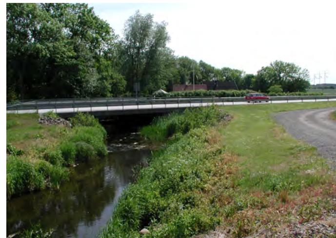
Befintlig bro över Bråån i Rolsberga
