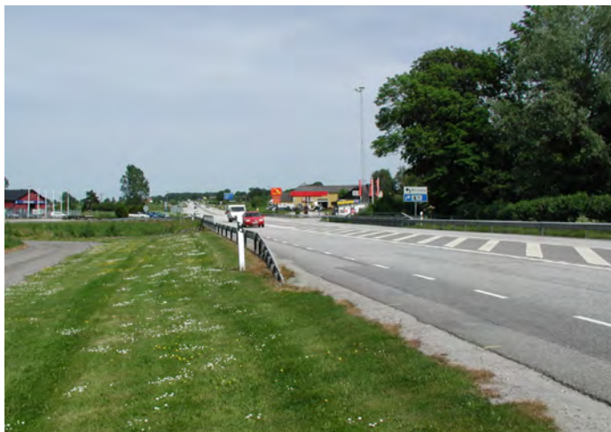
Befintlig väg E22, passagen genom Rolsberga
