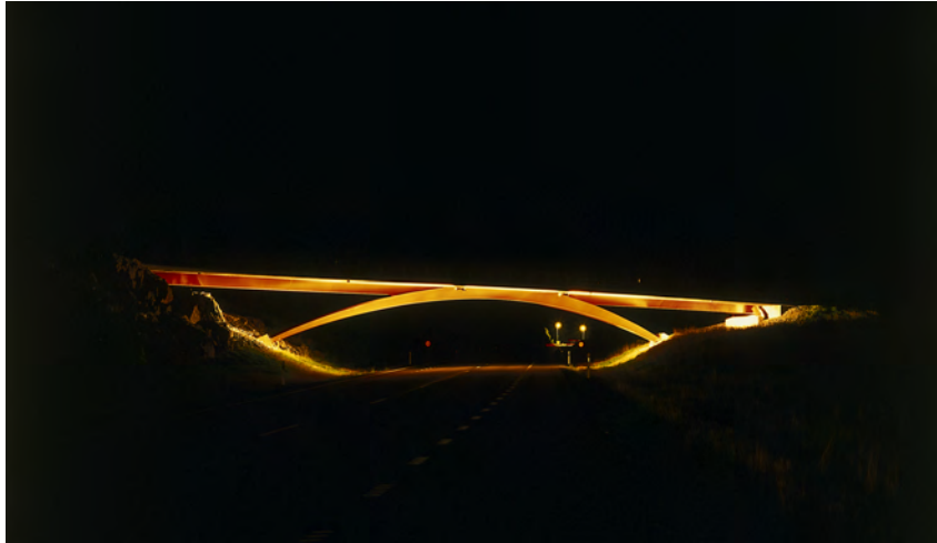
Exempel på effektbelysning av en bro.
