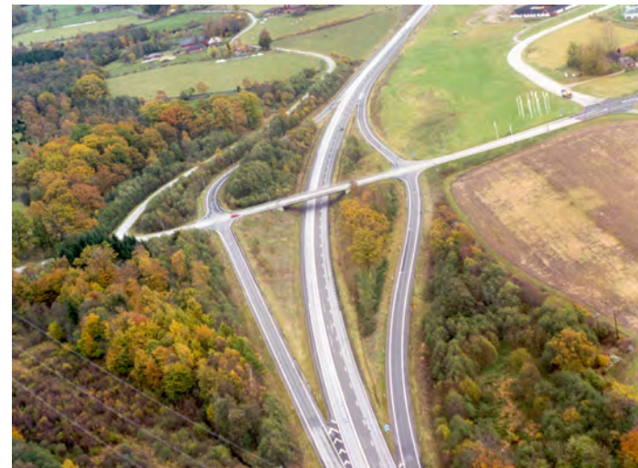
Trafikplats Hörby. Trafikplatsen bör kompletteras med vegetation för att förstärka väg E22's linjeföring.
