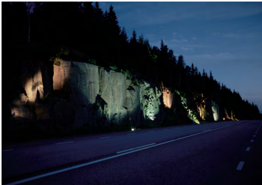
Ett exempel på hur ljussättning kan skapa spänning och dramatik i vägrummet. Bilden visar belysning av en bergskärning nära Skövde utmed väg 49. Ljusättare Chatarina Hennig
