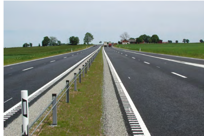
Exempel på mittremsa som är gräsbesådd och försedd med vajerräcke, väg E22 söder om Skarhult
