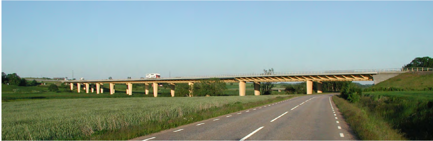
Bro över Rönne å väg E4, exempel på en landskapsbro över en flack och öppen dalgång.
