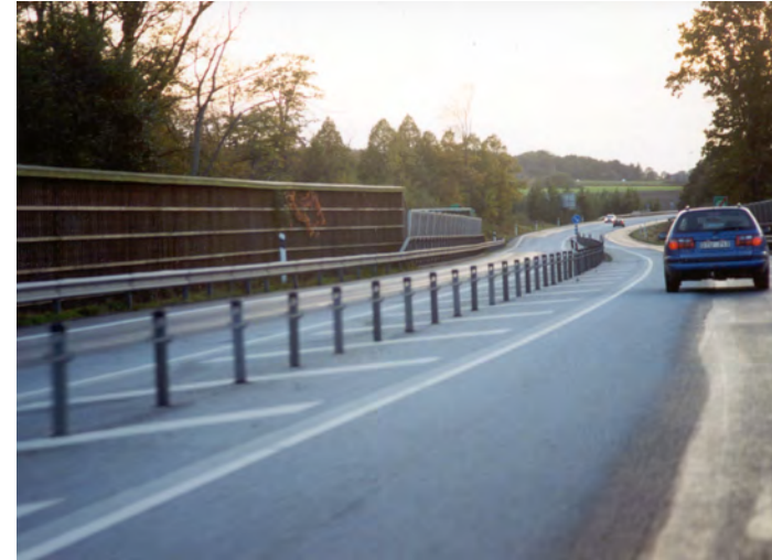
Väg E22 - bro över Hörbyån
