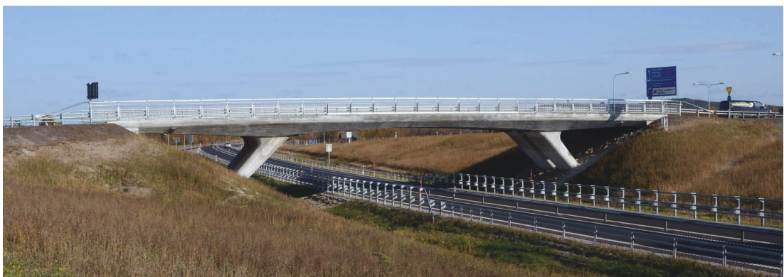
Figur 4.2-11 Exempel på en bro så kallad snedbening i Ersnäs. Bild från BaTMan
