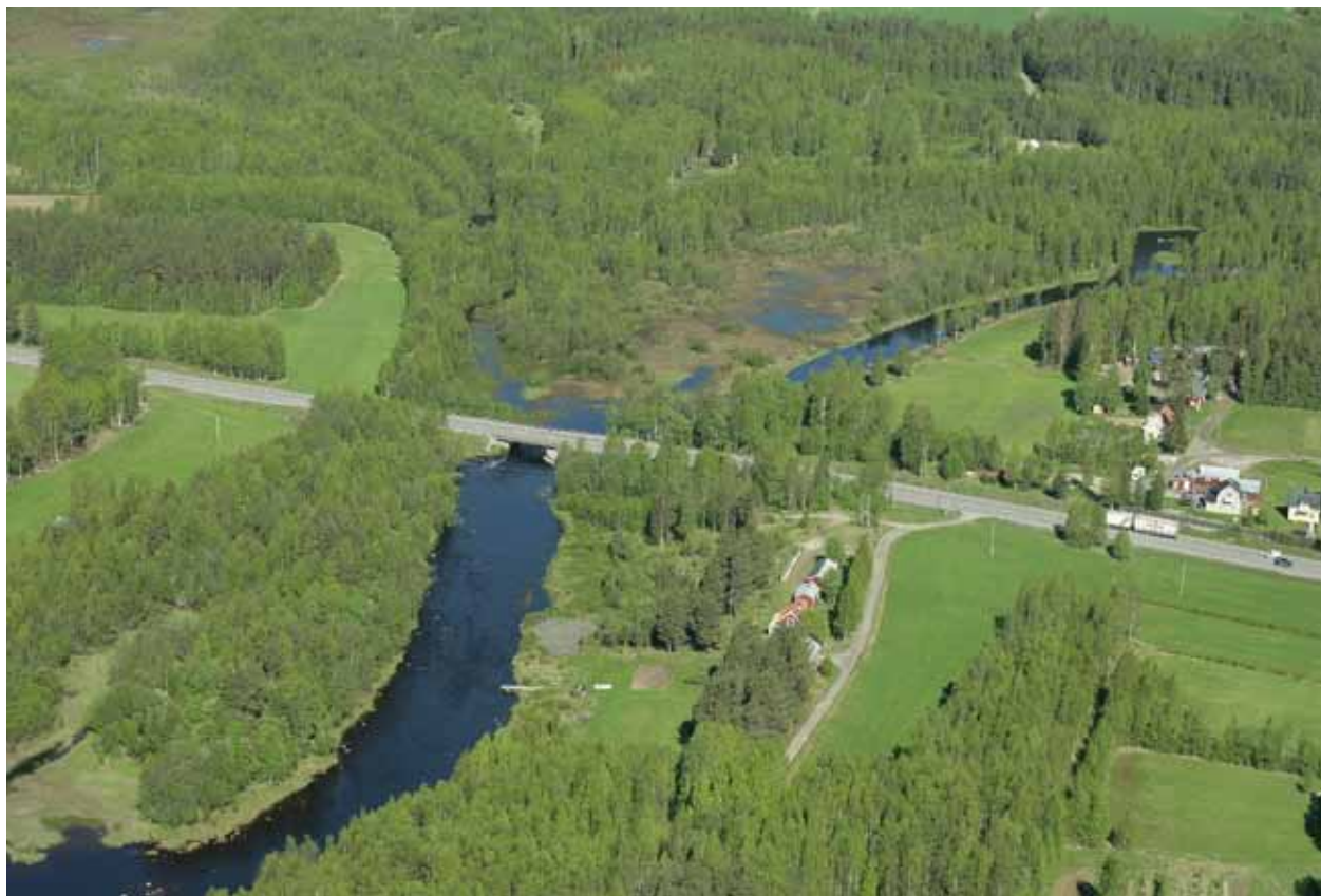
Figur 5.4.1 Flygfoto över E4 i Norrfjärden där vägen korsar Alterälven. I kommande skede, järnvägsplan, avgörs på vilken sida om E4 bron som järnvägen passerar vattendraget.
