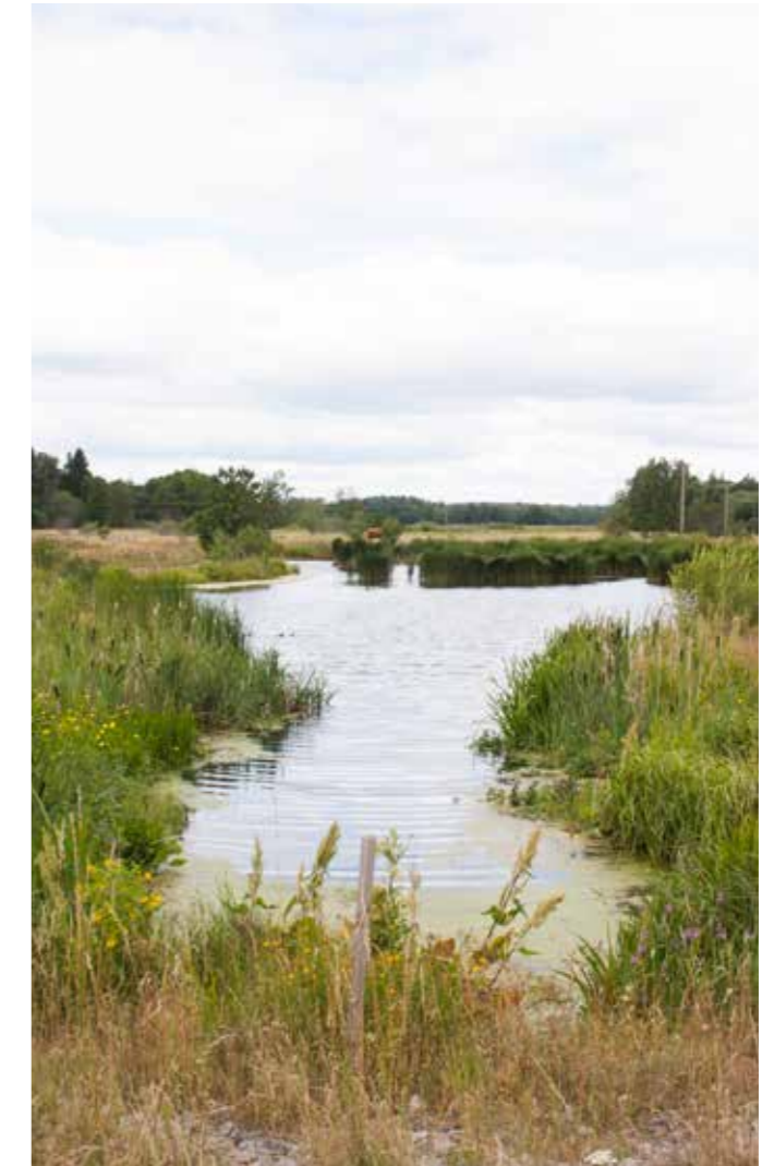
6.26 Dagvattendamm längs Almungevägen vid Vik.
