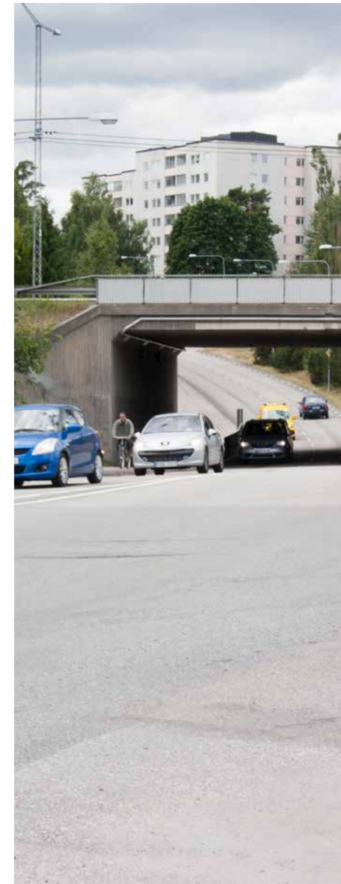
2.2 Almungevägens passage under E4 i Upplands Väsby.
