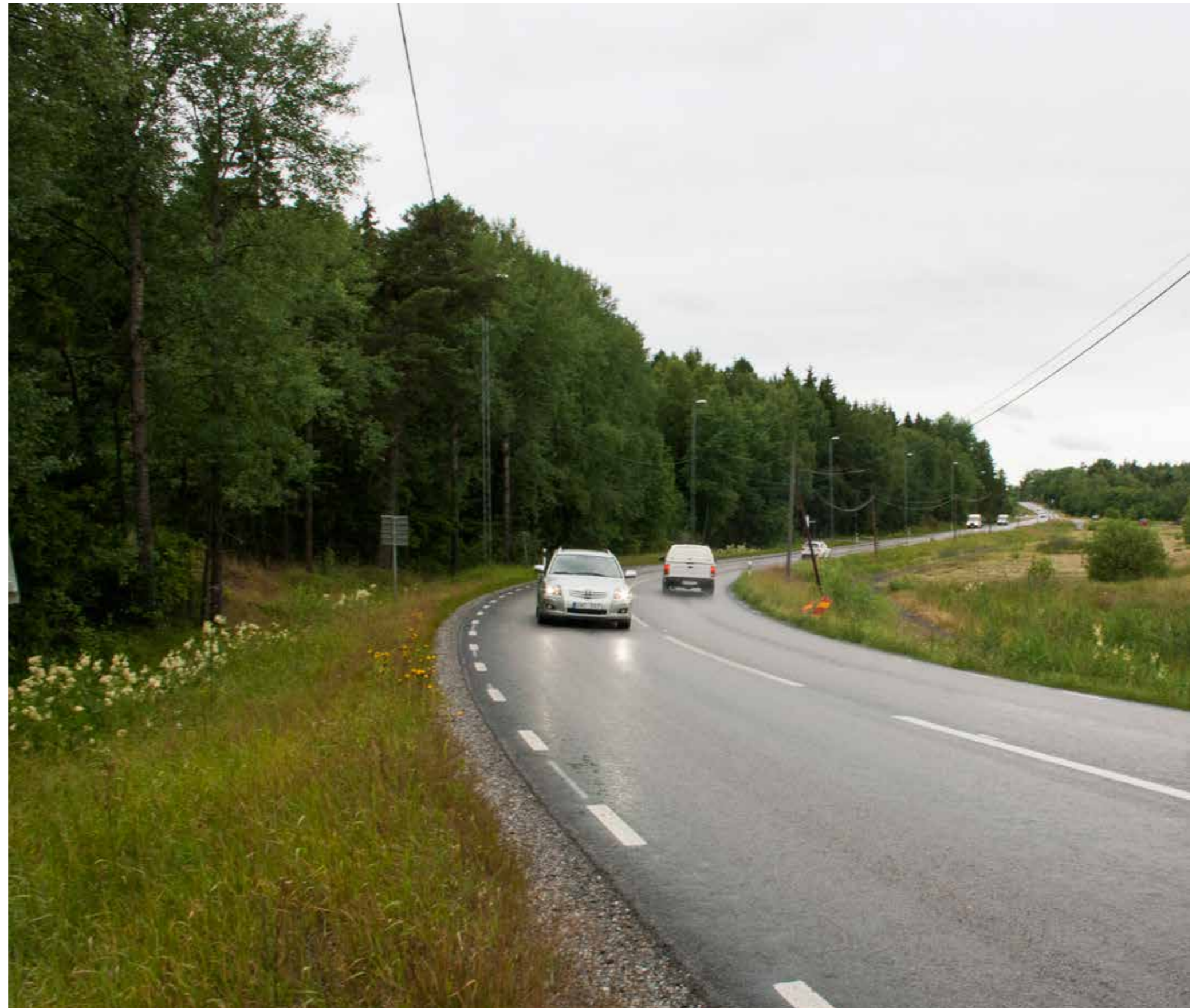
8.1. Kurvan vid Erikslund där korridor befintlig väg avviker från befintlig väg. Sett åt väster.
