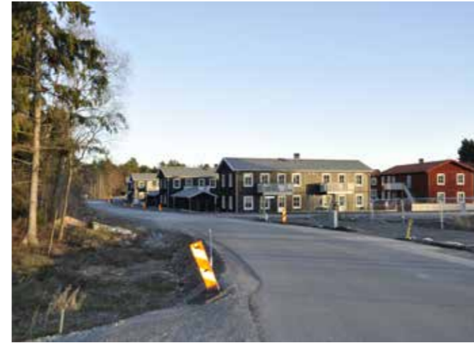
3.42 Nybyggda bostadshus vid Ekebyvägen
