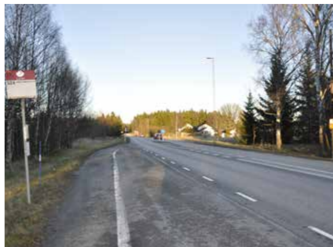
3.30 Väg 268, utsikt mot Lura från söder.
