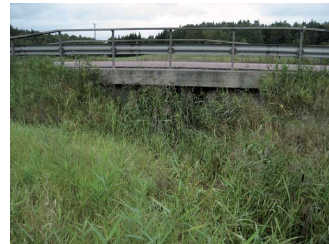
Figur 36. Dike som korsar väg 268.
