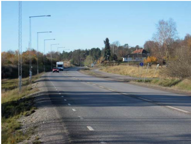
Figur 52. Belysningsstolpar är av eftergivlig typ på delar av sträckan.
