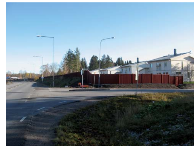
Figur 59. Bullerplank minskar störningarna för de som bor nära vägen.
