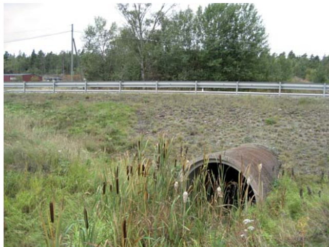
Figur 35. Betongtrumma som korsar väg 268.
