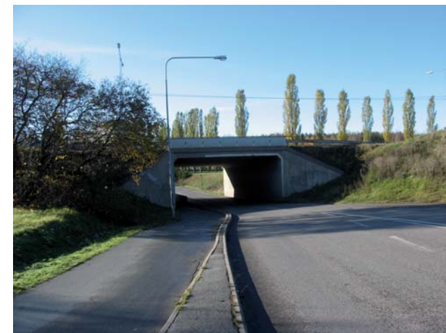
Figur 40. Vägport under E 4 vid Väsbyvägen.
