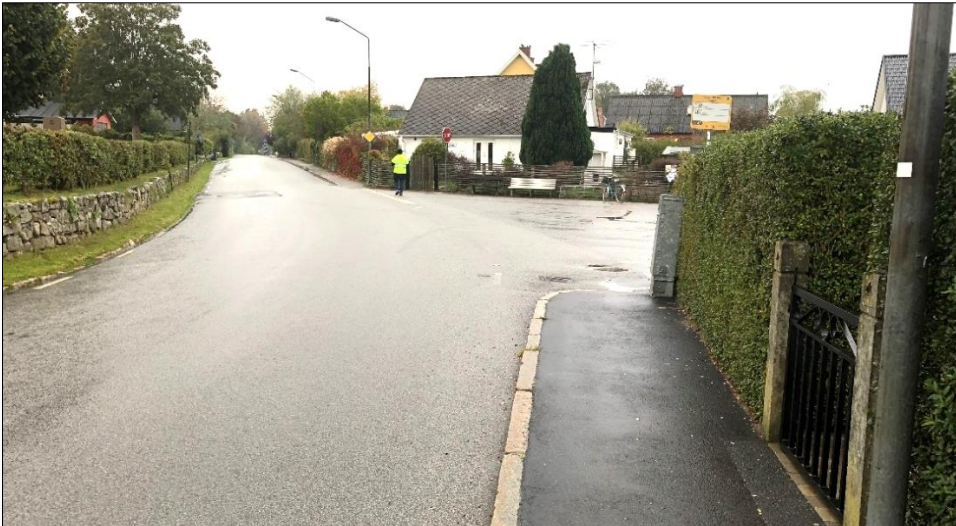
Figur 2. Området vid hållplatsen Torna Hällestad Torget. Läge A till höger i bild med trottoar, läge B till vänster intill stenmuren som omger kyrkogården.
