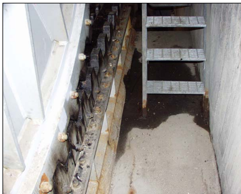
Rullbana och kuggsegment, Säffle
