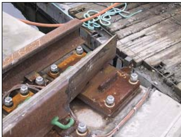
Centreringsregel och bladskarv , Köpmannebro
