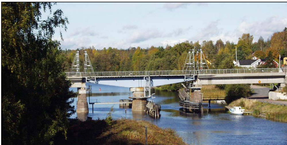
Figur 5-1 Foto av svängbro, Säffle
