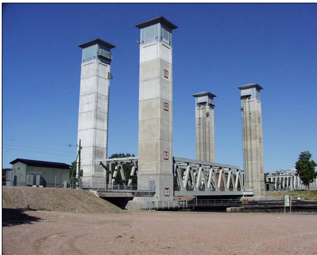
Figur 5-9 Foto av lyftbro, Trollhättan
