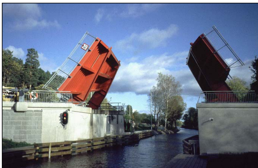
Figur 5-3 Foto av klaffbro, Strömma kanal
