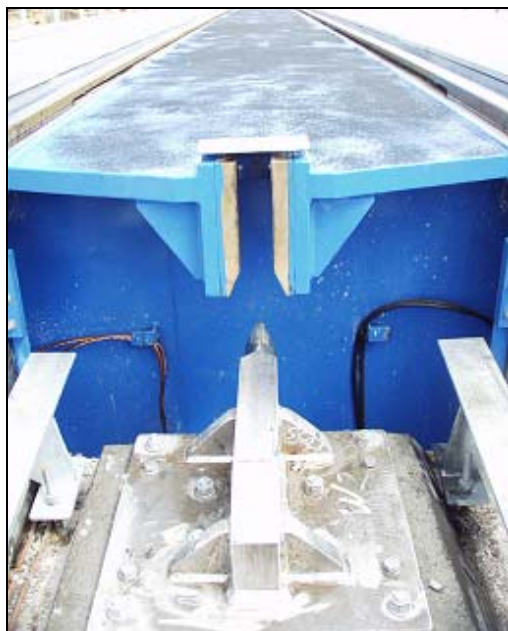
Centreringsregel och bladskarv , Köpmannebro
