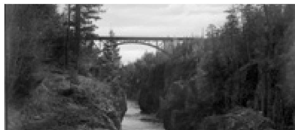
Järnvägsbro över Emån, Orsa. Uppförd 1902. Bild: Järnvägsmuseet
