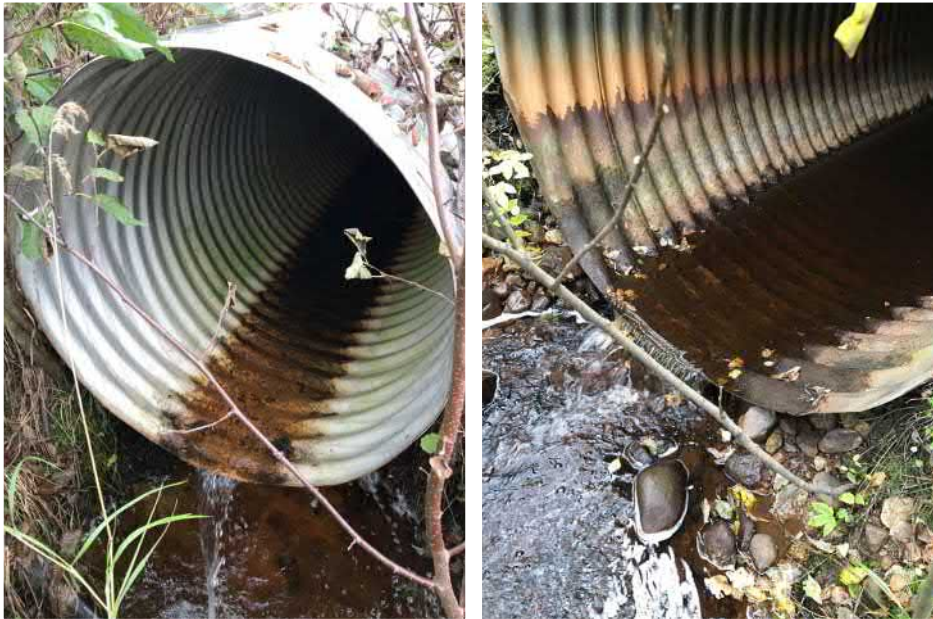
Figur 4:7. Exempel på stalp/vandringshinder i trummor längs den aktuella sträckan.
