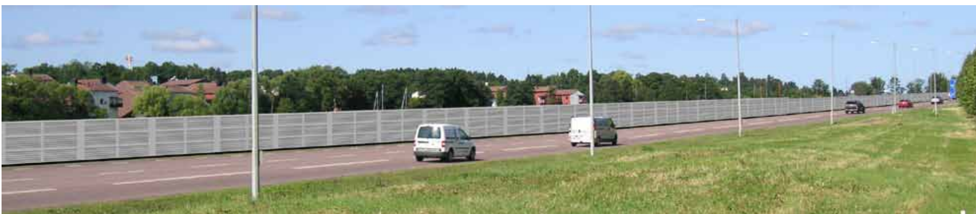
Figur 6.36 Fotomontage som visar bullerskärm på Lindö. Översta bilden visar nuläget, bilden i mitten visar en cirka 1 meter hög skärm vilket motsvarar den skärm som fastställs i planen. Den nedre bilden visar en cirka 2 meter hög skärm. Observera att vägbredd och väglinje i montage är samma som nuvarande situation.
