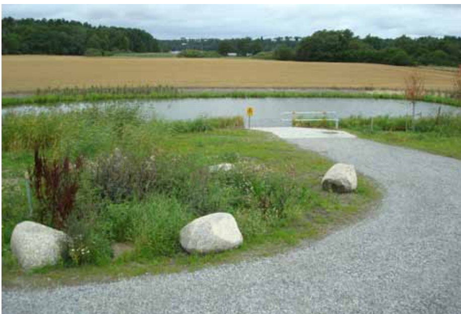
Figur 6.62 Dagvattendamm på Kärsön.
