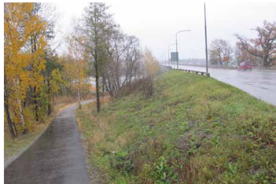
Figur 6.59 Dagens gångväg under Nockebybron.
