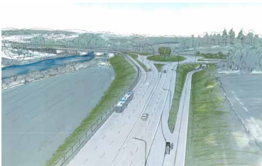
Figur 6.17 Cirkulationsplatsen blir större än idag och kommer tillsammans med vägbreddning och bullerskärmar förstärka vägens närvaro i området.
