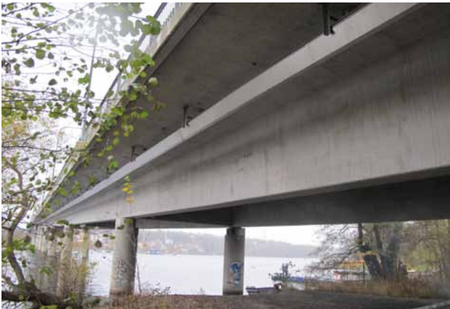
Figur 6.68 Under Nockebybron samlas idag vägdagvatten upp från ungefär halva bron och leds vidare till en reningsdamm på Kärösön. I framtiden kommer huvuddelen av Nockebybrons vägdagvatten att ledas på samma sätt till denna dagvattendamm.
