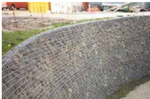
Exempel på en brant gabionmur. Bildkälla Byggros.
