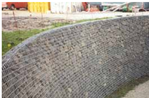
Exempel på en brant gabionmur. Bildkälla Byggros.
