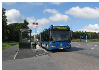
Bild 16. Asfalt på körbanor och trottoar, vid Karusellplan.
