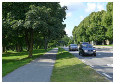
Bild 17. Parkvägen utmed Ekerövägen har idag ljus asfalt.
