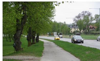
Bild 78. Nuläge: Vy längs med Ekerövägen mot väster.
