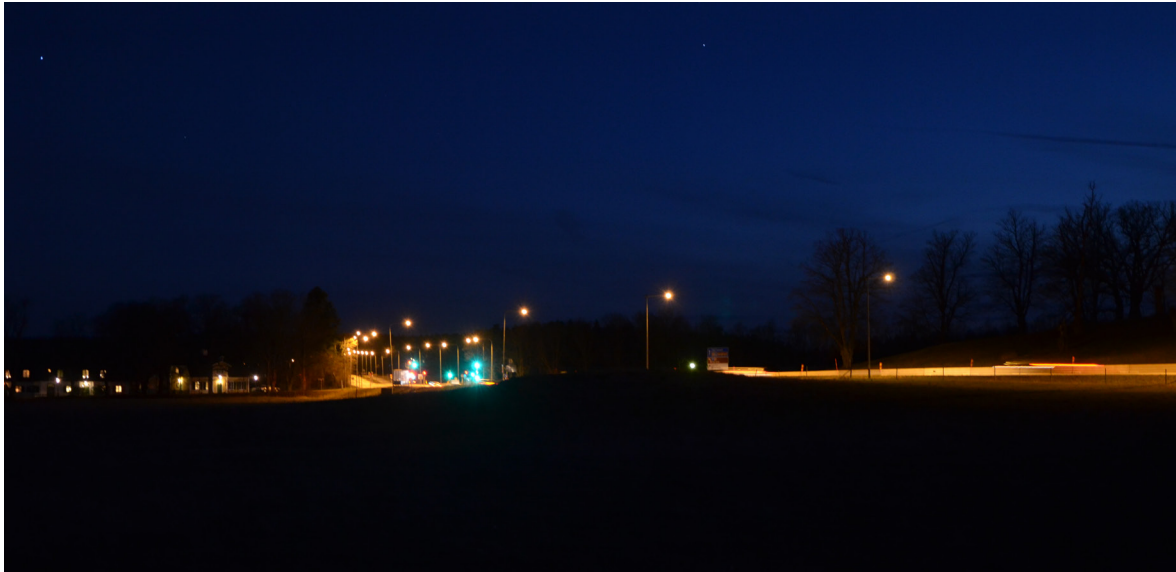
Bild 39. Från vägen nedanför Götiska tornet mot Kanton. Nuläge kvällstid. Observera att när bilden togs pågick ett vägarbete.
