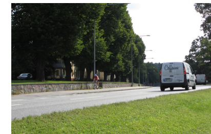
Bild 6. Stödmuren utmed Malmen.
