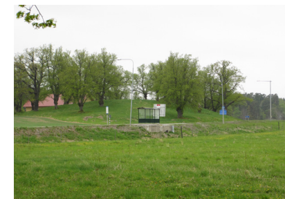
Bild 73. Nuläge: Vy från Skollén mot Ekerövägen och busshållplatsen Kanton, östergående. Bakom syns tydligt den kulle med ekar och mellan träden skymtar den engelska ladan. Notera det grova betongfundamentet i bakkant av vädskyddet och de olika typerna av belysningstolpar som står utmed sträckan.
