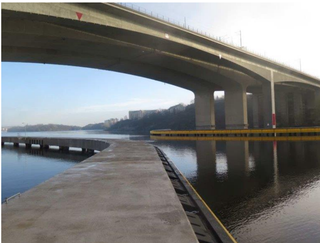
Figur 5. Kollisionsskydd i form av ledverk vid Gröndalsbron, som består av betongbalkar på vardera sida om farleden.
