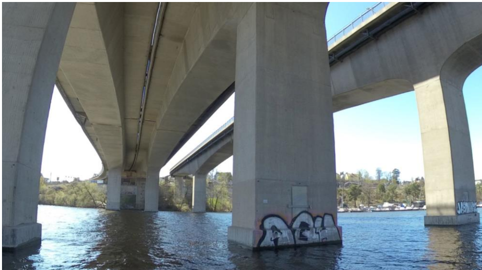
Figur 11. Direkt under Essingebro är landskapet redan starkt präglad av bron storskaliga pelare, som på sina ställen blivit canvas för graffiti. Här är landskapets känslighet lägre för förläggning av de framtida kollisionskyddens nya betongkonstruktion.
