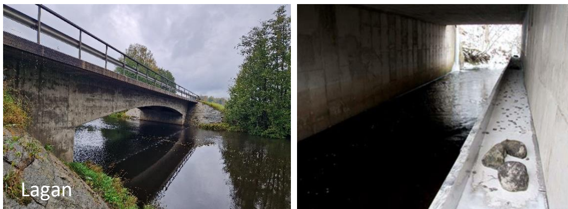
Figur 29. Till vänster: Befintlig bro över Lagan. Till höger: Exempel på vilthylla med ingjutna markeringsstenar. (Trafikverket).
