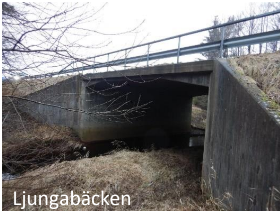
Figur 31. Befintlig bro över Ljungabäcken.
