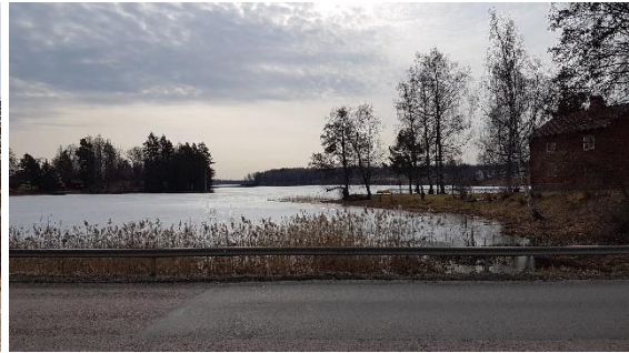
Figur 23; Vid busshållplatsläget ligger vägen direkt mot sjön.
