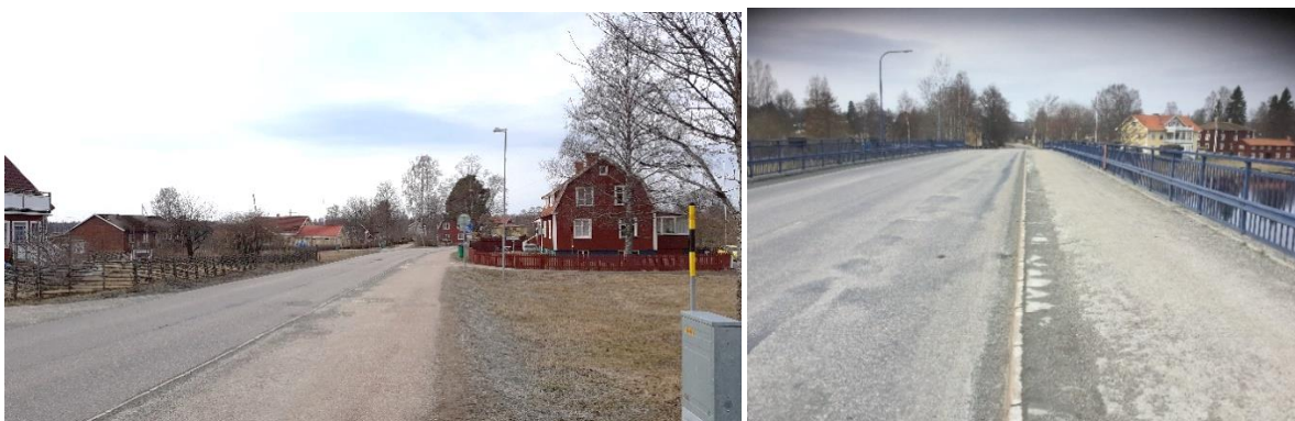
Figur 14, 15; Befintlig gång-och cykelväg från Klockargatan till korsning 671-673
