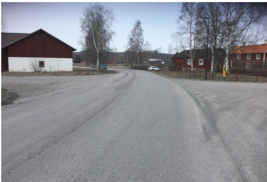
Figur 5; Korsning Väg 671-Bergsmansvägen
