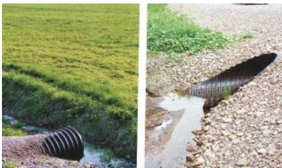
Bild 18. Skillnad på trumändar. Snedskuren ger bättre anpassning. Foto ur "Dalslands vägmiljöer".
