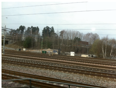
Figur 1.4 Mäljarbanan sedd från Ostkustbanan.
