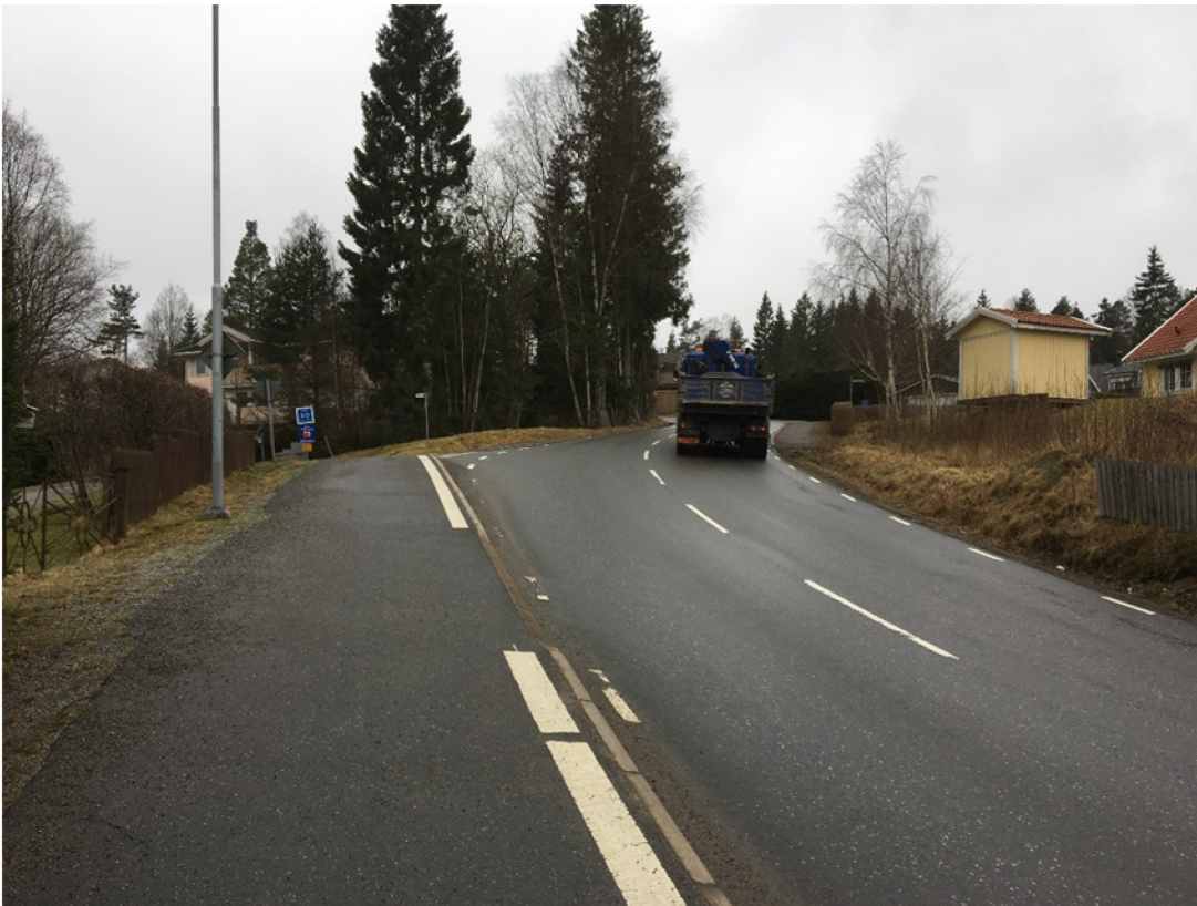
Figur 4. Söder om aktuell vägsträcka finns en befintlig gång-och cykelväg som avgränsas av kantsten mot gatan. Detta bidrar till en gatukaraktär istället för en landsvägskaraktär utmed den sträckan.
