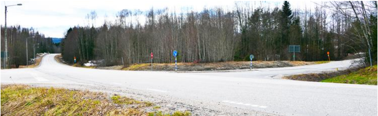
Inom kort påbörjar vi arbetet med att bygga om väg 86 förbi Kovland.
