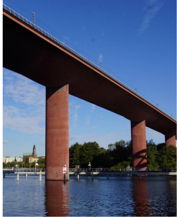
Figur 37. Västra Årstabron i Stockholm är ett exempel på en hög bro med kort brospann med brostöd i vattnet (segelfri höjd är 26 meter).
