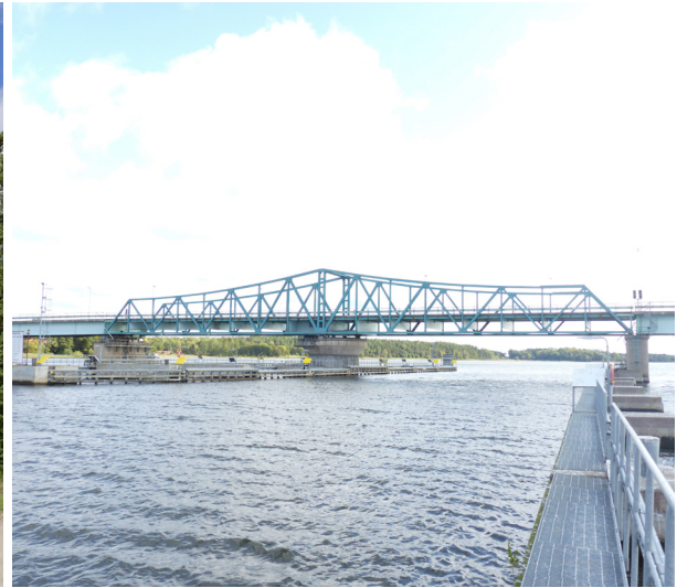
Figur 40. Till vänster: Järnvägsbron över Södertälje kanal är ett exempel på en låg bro av typen lyftbro (segelfri höjd i maximalt upplyft läge är 41,5 m och i tågtrafikläge är bron 26 m hög). Hjulstabron över Mälaren söder om Enköping är ett exempel på en låg bro av typen svängbro.
