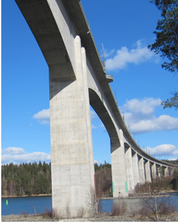
Figur 36. Igelstabron i Södertälje är ett exempel på en hög bro med långt brospann utan brostöd i vattnet (segelfri höjd 39,9 meter).
