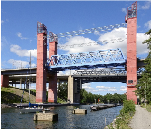
Figur 40. Till vänster: Järnvägsbron över Södertälje kanal är ett exempel på en låg bro av typen lyftbro (segelfri höjd i maximalt upplyft läge är 41,5 m och i tågtrafikläge är bron 26 m hög). Hjulstabron över Mälaren söder om Enköping är ett exempel på en låg bro av typen svängbro.
