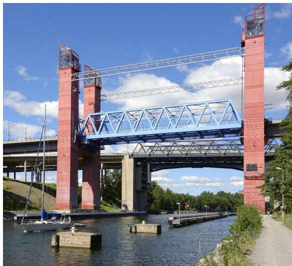
Figur 7.4-3. Till vänster: Järnvägsbron över Södertälje kanal är ett exempel på en öppningsbar bro av typen lyftbro (segelfri höjd i maximalt upplyft läge är 41,5 meter och i tågtrafikläge är bron 26 meter hög). Till höger: Hjulstabron över Mälaren söder om Enköping är ett exempel på en öppningsbar bro av typen svängbro med brostöd i vattnet.
