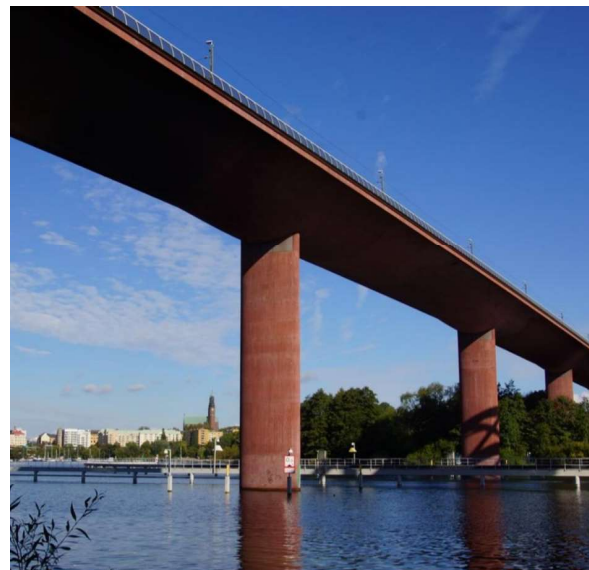
Figur 7.4-1. Till vänster: Igelstabsbron i Södertälje är ett exempel på en fast bro med långt brospann utan brostöd i vattnet (segelfri höjd 39,9 meter). Till höger: Västra Årstabron i Stockholm är ett exempel på en fast bro med kort brospann med brostöd i vattnet (segelfri höjd är 26 meter).
