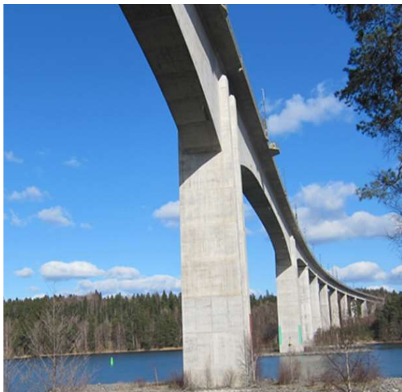
Figur 7.4-1. Till vänster: Igelstabsbron i Södertälje är ett exempel på en fast bro med långt brospann utan brostöd i vattnet (segelfri höjd 39,9 meter). Till höger: Västra Årstabron i Stockholm är ett exempel på en fast bro med kort brospann med brostöd i vattnet (segelfri höjd är 26 meter).
