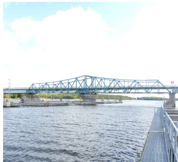
Figur 7.4-3. Till vänster: Järnvägsbron över Södertälje kanal är ett exempel på en öppningsbar bro av typen lyftbro (segelfri höjd i maximalt upplyft läge är 41,5 meter och i tågtrafikläge är bron 26 meter hög). Till höger: Hjulstabron över Mälaren söder om Enköping är ett exempel på en öppningsbar bro av typen svängbro med brostöd i vattnet.
