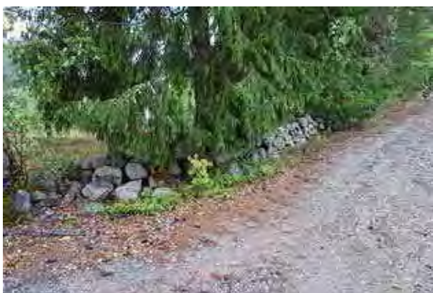
Fig. 113. Stenmur (10) av rundade stenar, något skadad närmast vägen. Foto mot N.
