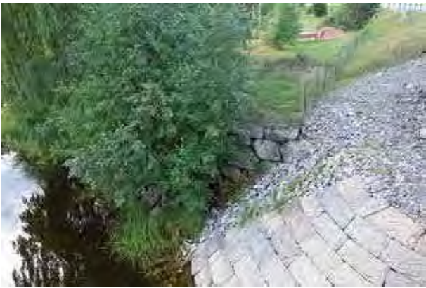
Fig. 37. Brofäste (22) och del av vägbank gömt i buskarna på Norrboåns NV strand. Foto mot NV.
