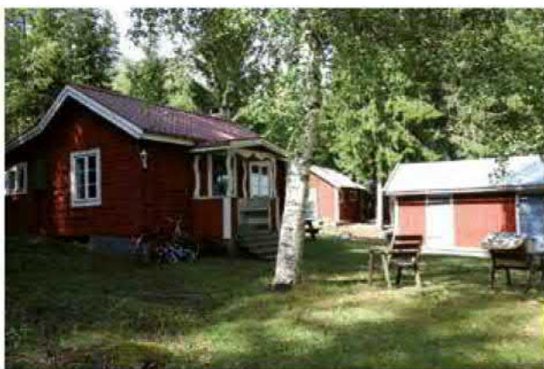
Fig. 110. Platsen för Kruts soldattorp (L1951:4335/Forsa 243:1). Gamla torpet ska ha brunnit ned och det är inte det ursprungliga torpet som står där idag. Foto mot V.
