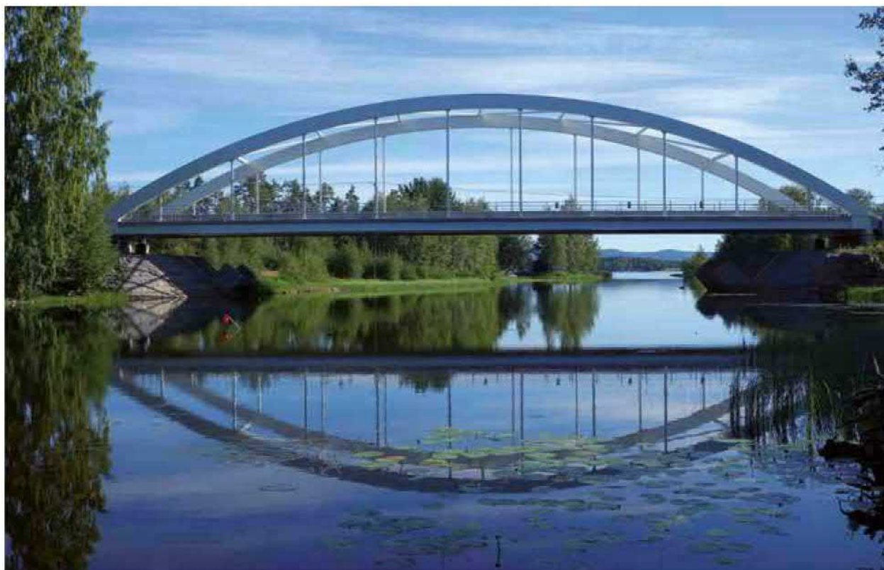
Fig. 4. Bro över Norrbo ån, mellan Norrdellen och Sördellen. Vid utredningen noterades äldre brofästen strax hitom befintlig bro, på båda sidorna av ån. Foto mot NÖ.
