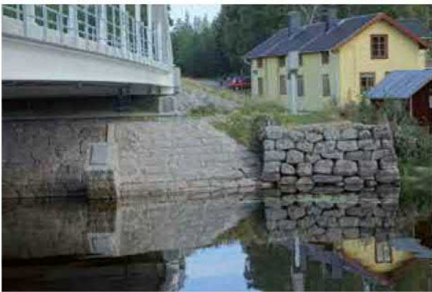
Fig. 38. Brofäste (22) på Norrboåns SÖ strand. Foto mot SÖ.
