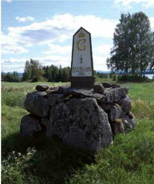
Fig. 61. Milstolpe (L1950:1662/Norrbo 13:1), eventuellt i ett ursprungligt fundament men som bättrats på med cement. Foto mot S.
