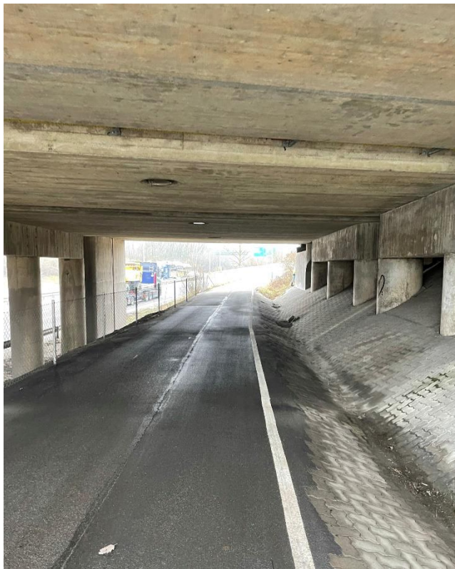
Figur 5.4. Gång- och cykelväg under järnvägen.
