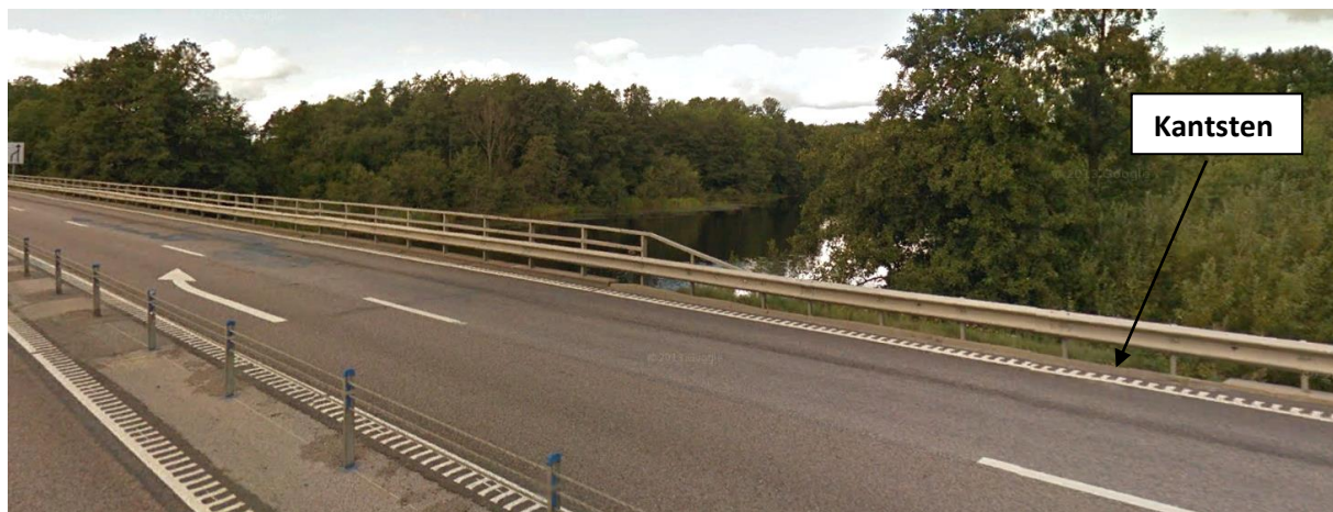
Figur 45. Vid passage av Lyckebyån har vägen försetts med kantsten.
