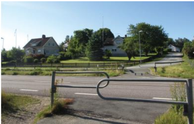
Figur 37. Passage över E22 vid Ramdala.
