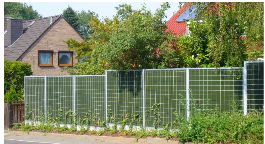
Exempel på grönt polyplank med spaljéer för klätterväxter intill villaträdgårdar.
