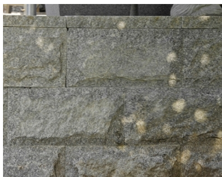
Exempel på mur med beklädnadssten.
