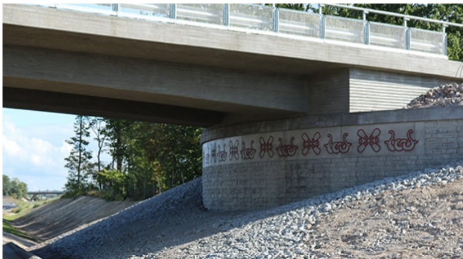
Exempel på bro med rundat fäste och mönster vid E22 Rinkabyholm.
