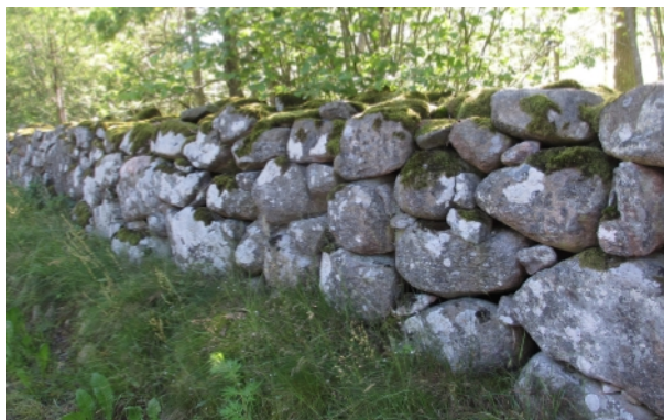
En välgjord stenmur norr om Vallby återspeglar de kulturhistoriska perspektiven och förstärker vägens riktning.
