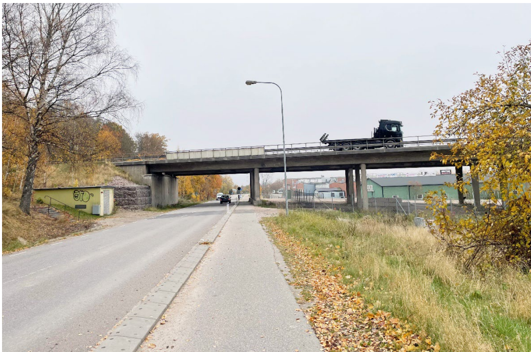
Figur 14. Foto från Blommenhovsvägen från väst mot öst, mot de befintliga motorvägsbroarna. På andra sidan de befintliga motorvägsbroarna syns det industriområde där Nöthagen planeras. Hemgårdspassagen kommer att byggas till höger i bild. Den skogsbeklädda höjden och den branta sluttningen syns till vänster i bild.
