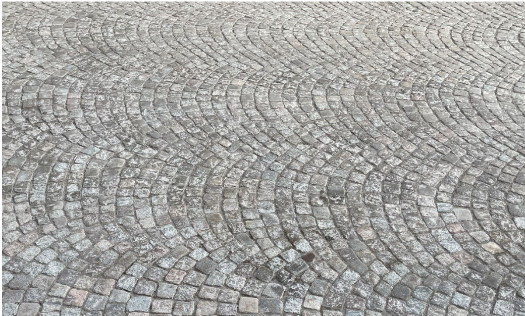
Figur 29. Exempel stenbeläggningar av smågatsten som skulle kunna användas för det norra landfästets slänter.
