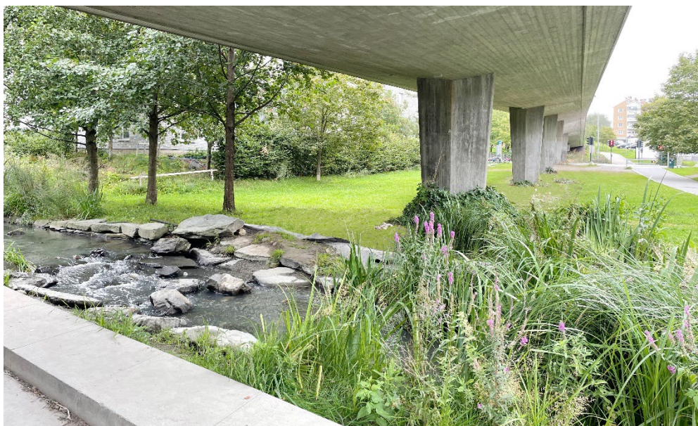
Figur 44. Exempel på yta under bro i Oslo som utnyttjas för dagvattenhantering vilket även möjliggör för växtlighet.
