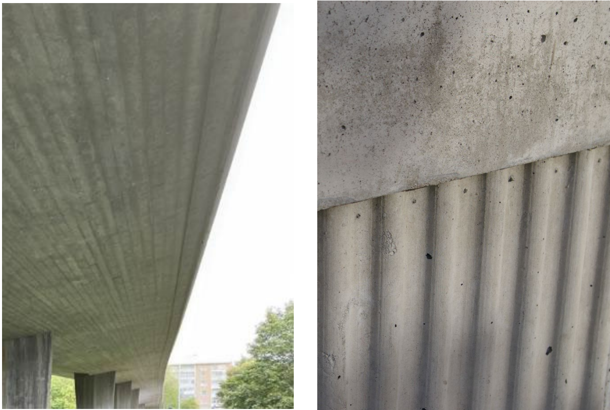
Figur 24-25. Exempel på bro med rundad kantbalk samt bearbetning av betongyta.
