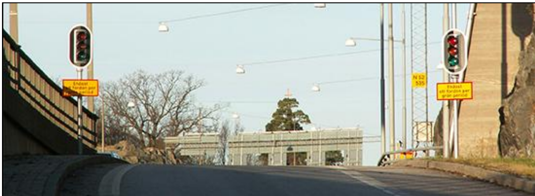
Figur 15. Exempel på påfartsreglering till Essingeleden. Källa: Trafikverket.
