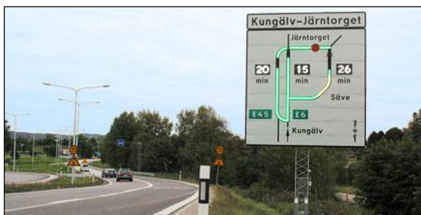
Figur 10. Exempel på digital skyltning. Vid köbildning skiftar länkarna färg från grönt till gult och rött, vilket underlättar vägvalet med avseende på restid. Källa: Svevia.
