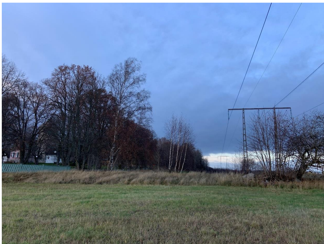
Bild 1. Norrsunda kyrka på den västra sidan, Svenska kraftnäts befintliga 220 kV kraftledning på den östra sidan, bild tagen mot norr. Trafikverkets planerade ledning planeras korsa Svenska kraftnäts ledning och därmed passera på båda sidor om den befintliga ledningen.
