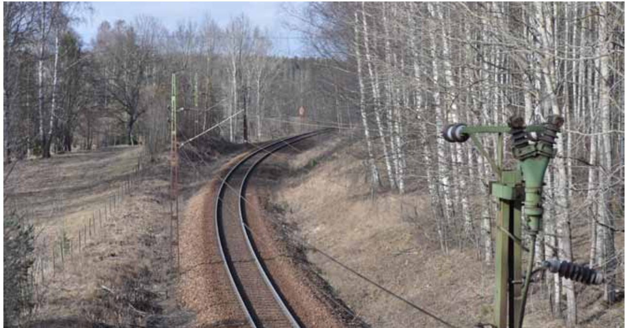
Bild 4.2 Kurva söder om passage över västra stambanan.
