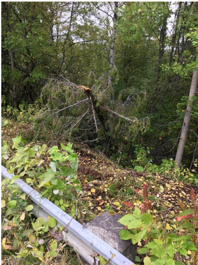
Figur 3. Längs sträckan Krångfors 2 syns spår av de senaste årens ras och skred.
