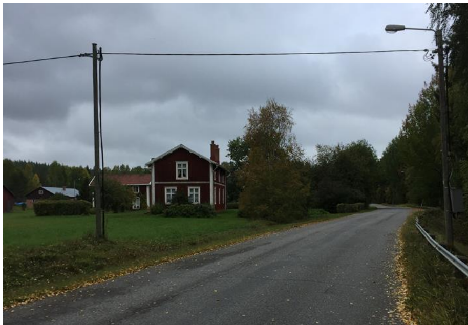
Figur 11. Korsande ledningar och belysning längs väg 791
