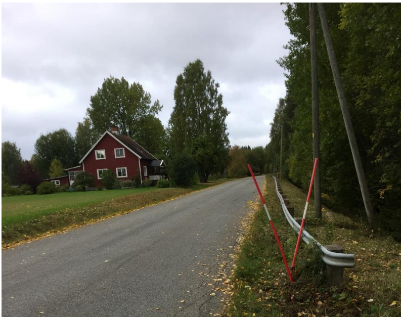
Figur 8. Bebyggelse intill väg 791.
