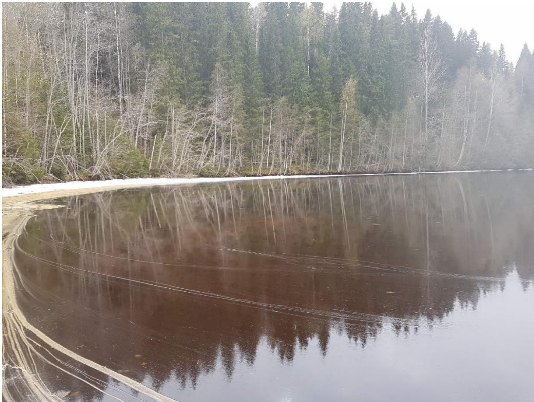
Figur 5.4-2. Överblick över Krångorsdammen för platsen av anläggandet av erosionsskydd.
