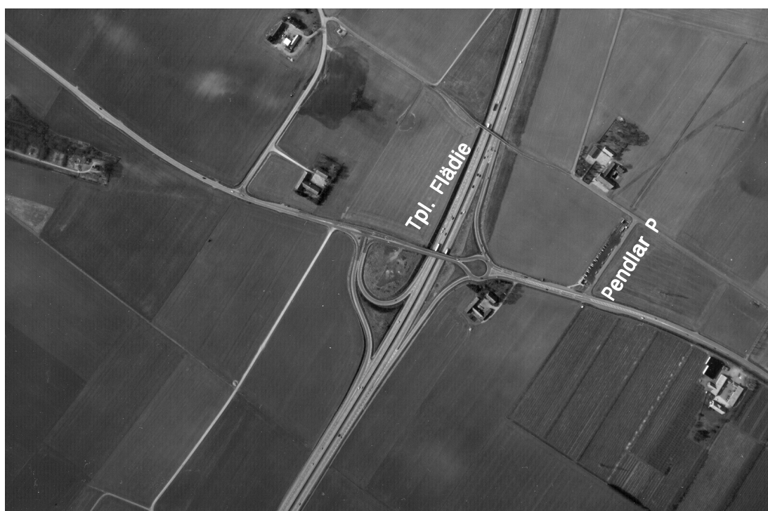
Flygbild över Trafikplats Flädie. Dagens pendelparkering syns till höger.
