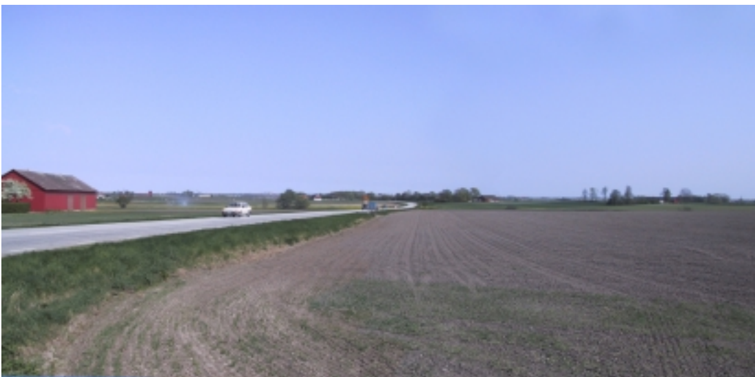
Väg 913 söder om Flädie i riktning mot Lund
