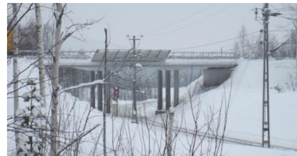
Bild 2.22 Passagen av järnvägen kan ske planskilt antingen över eller under järnvägen för oskyddade trafikanter, beroende på bland annat de byggnadstekniska förutsättningarna.
