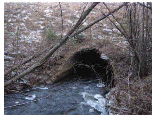
Bild 2.23 Korsträskbäcken passerar väg 94 med rörbro.
