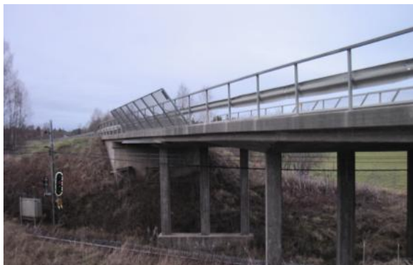
Bild 2.11 Väg 94 passerar över järnvägen strax innan Korsträsk.
