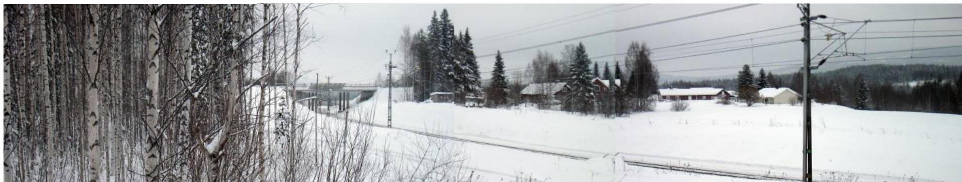
Bild 3.1 Järnvägen och passage väg 94 på bro. En gång- och cykelväg ska passera järnvägen planskilt antingen på bro eller i port under järnvägen. Vy från södra delen av Korsträsk, vid Smedjevägens slut.
