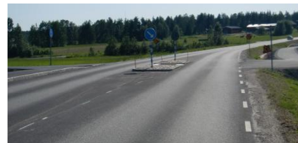
Bild 5.13 Exempel på passage med utförda tillgänglighetsåtgärder i Bensbyn, Luleå.
