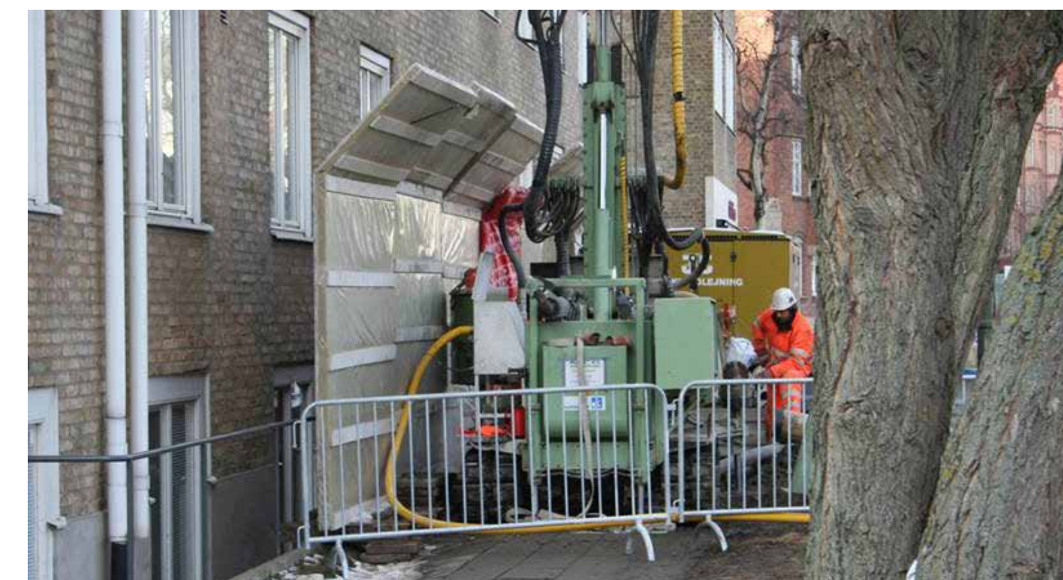
Exempel på bullerskyddsskärm vid byggarbete nära bostadshus.
