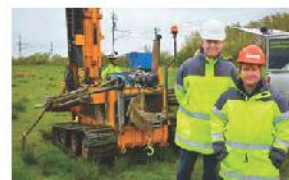
BORRMASKIN. Från och med nästa vecka kommer de gula maskinerna vara synliga i stan, och arbetet kan medföra vissa mindre trafikstörningar. Till vänster Anders Sundberg, till höger Pia Larsson.
